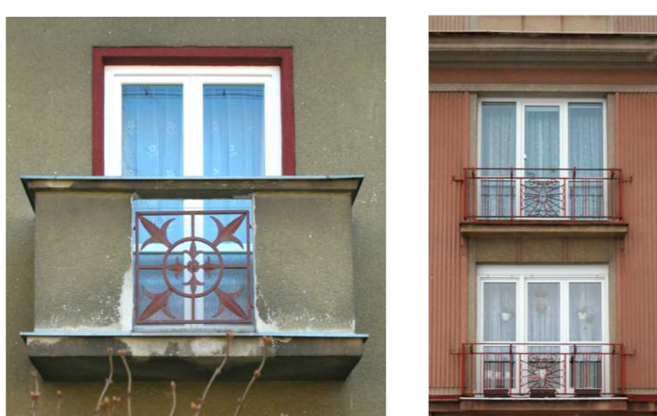
Zábradlí balkonů obytných domů, Březová
